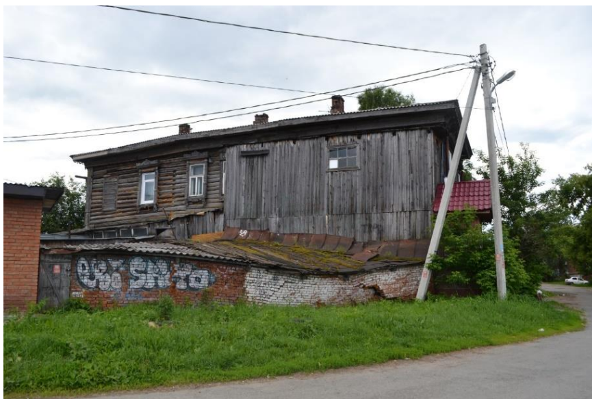
Рис.6 Фрагмент восточного фасада, ул. Максима Горького,8.
