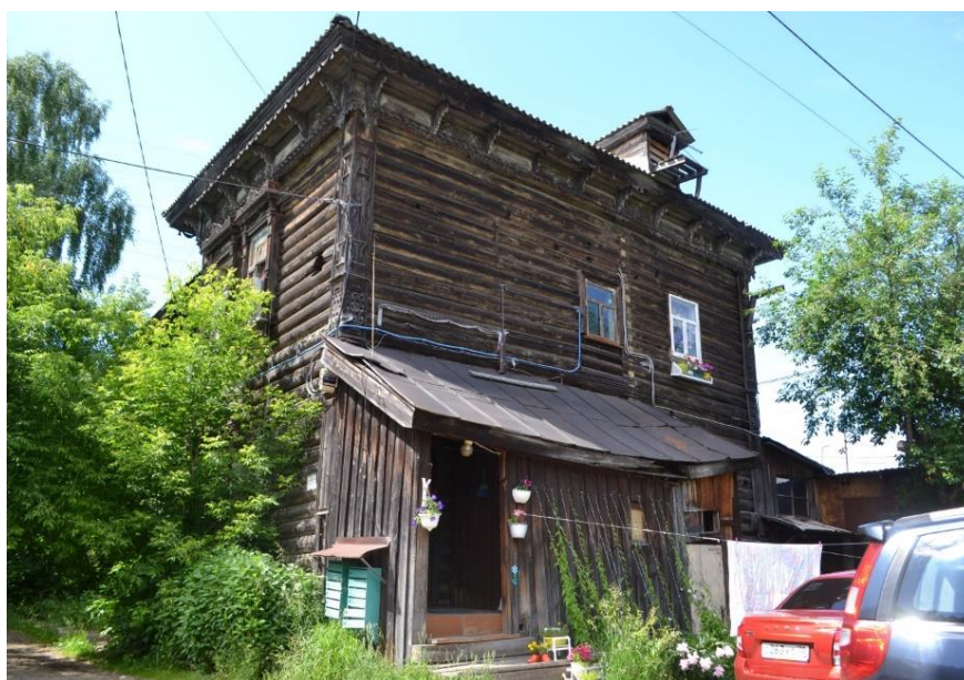
Рис.5 Фрагмент западного фасада, ул. Максима Горького,8.
